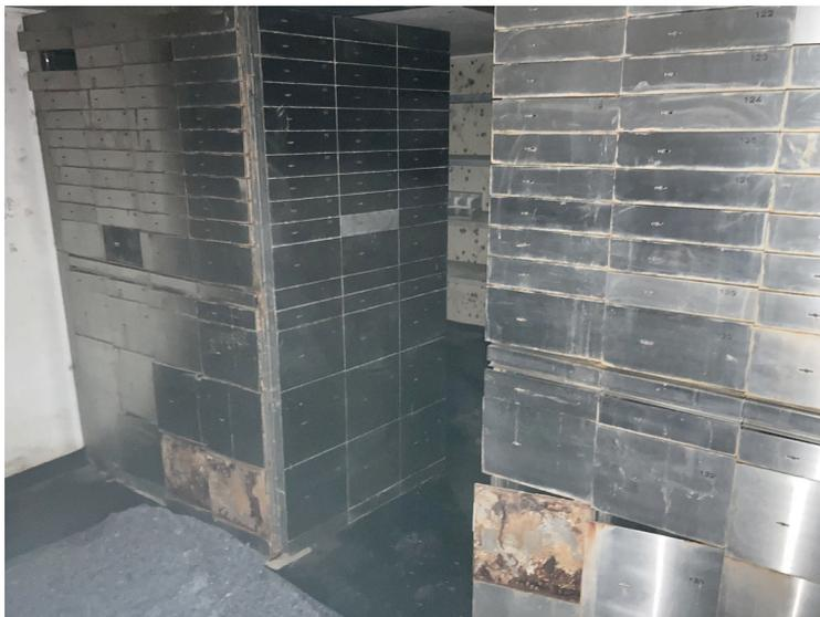
Durch Hochwasser beschädigte Safefachanlage
